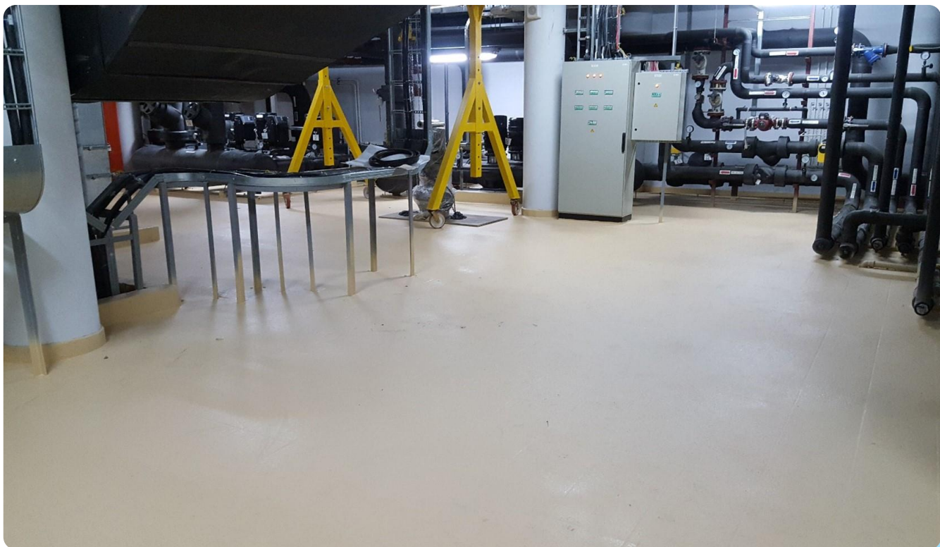
▶ Гидроизоляция пола (плитка) вентиляционной камеры
