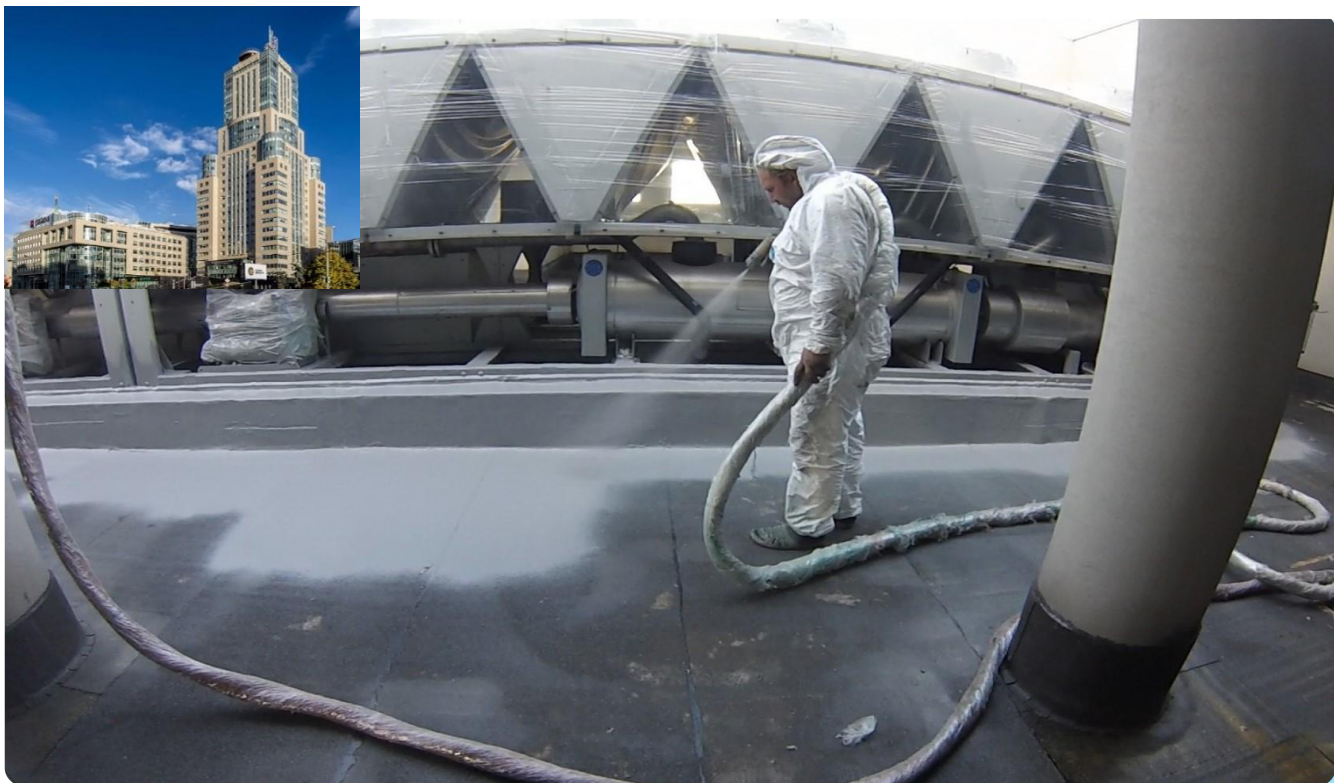
▶ Гидроизоляция пола (плитка) вентиляционной камеры
